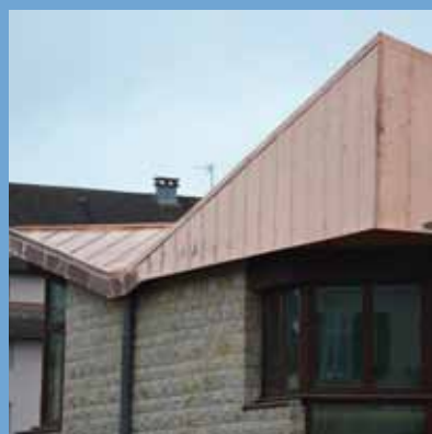
Exemple d'investissements dans ce domaine en 2014 – toiture des Capucins
