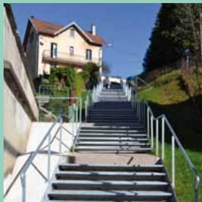
Exemple d'investissements dans ce domaine en 2013 – escalier rue des Lauaux
