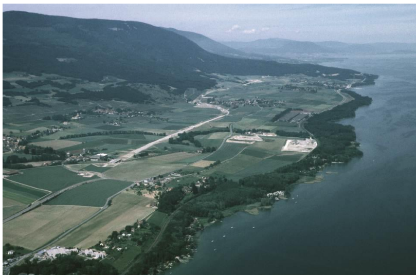
Vue aérienne en direction du nord-est de la partie vaudoise du chantier de l'autoroute A5 au pied du Jura. Des fouilles archéologiques préventives ont été réalisées sur ce tracé entre 1995 et 2004.
