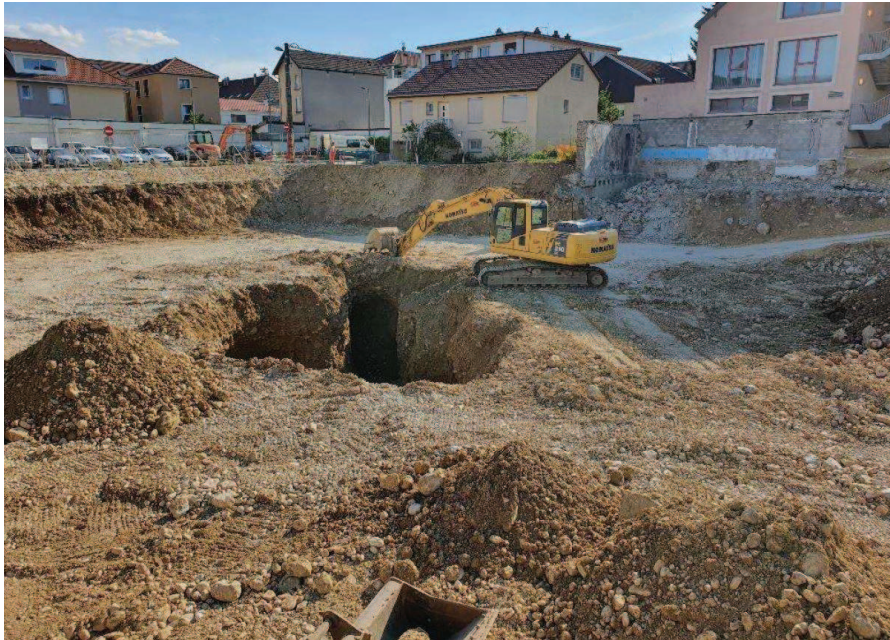
Travaux de dépollution sur lot H8 – Septembre 2020
