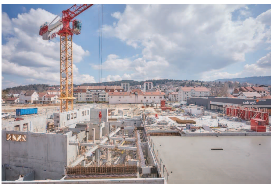
Lot H.8 en cours de construction
