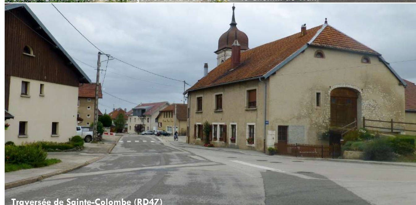
Croisement de la rue de Besançon et de la voie douce « le Chemin du Train »
