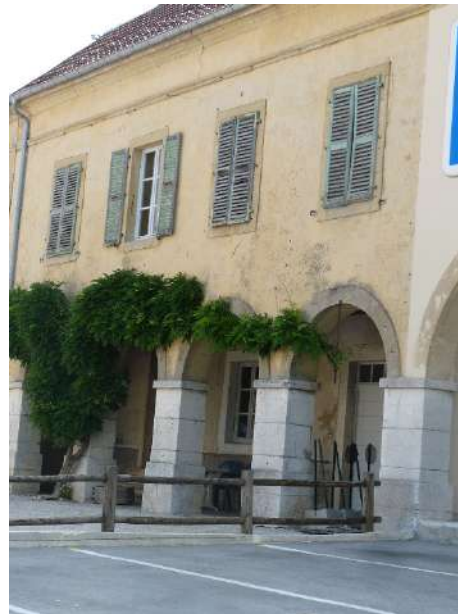
Immeuble avec galeries, Doubs
