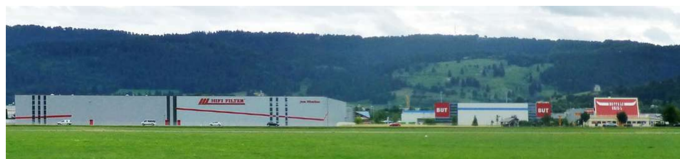
Vue depuis la route sur le début de la zone d’activité des Grands Planchants, ceinture commerciale sur la commune de Pontarlier
