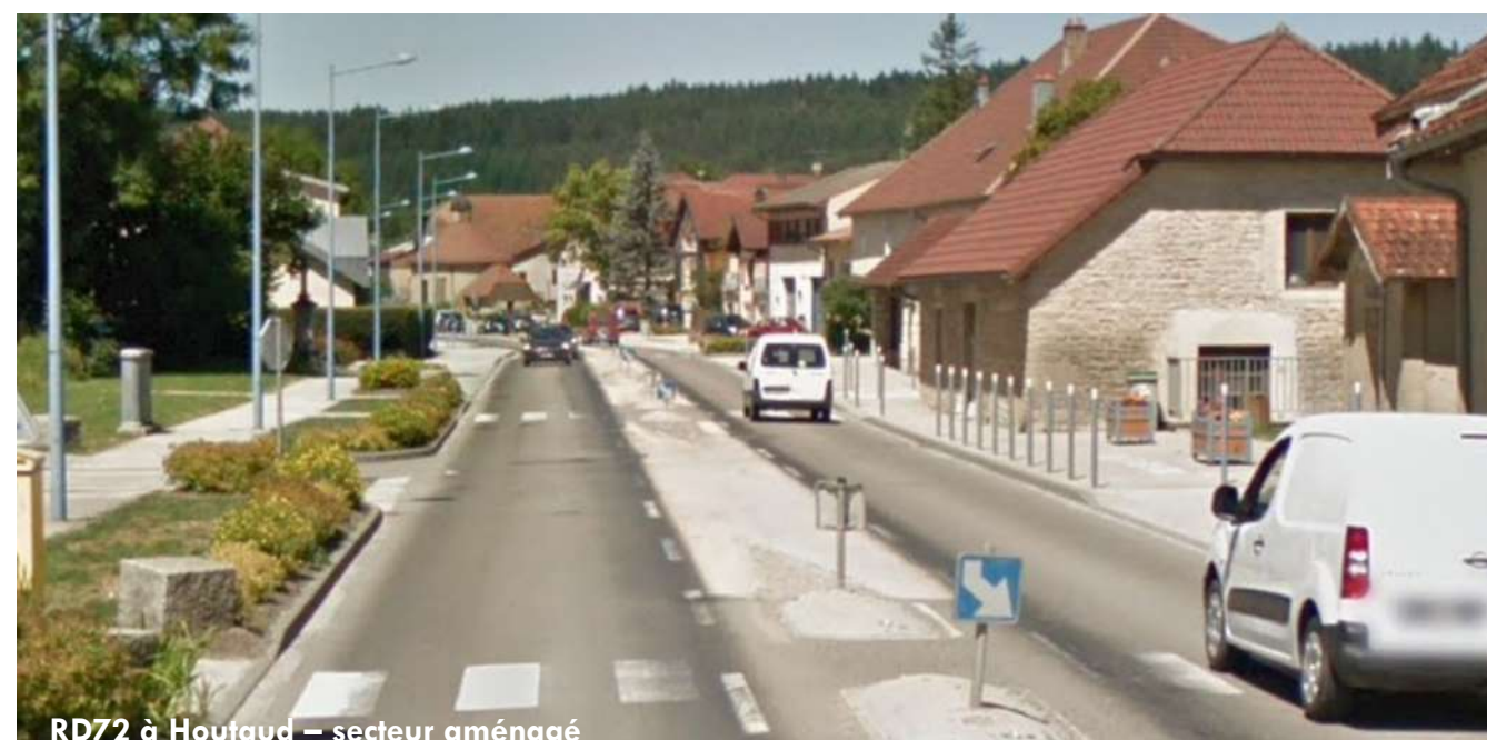
RD72 à Houtaud – secteur non-aménagé
