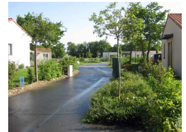
Voie tertiaire-voie partagée (voitures, piétons, vélos) à sens unique Treize-Septiers (85) - La Papinière
