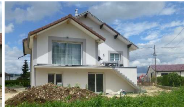
Vue arrière de la maison
