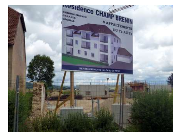
Démolition/reconstruction (relique du mur), Houtaud
